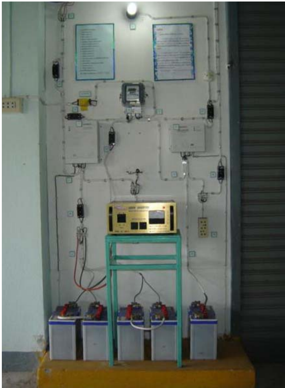
รูปแสดงระบบควบคุมไฟฟ้าแสงอาทิตย์ อาคาร ศูนย์เทคโนโลยีที่เหมาะสม
